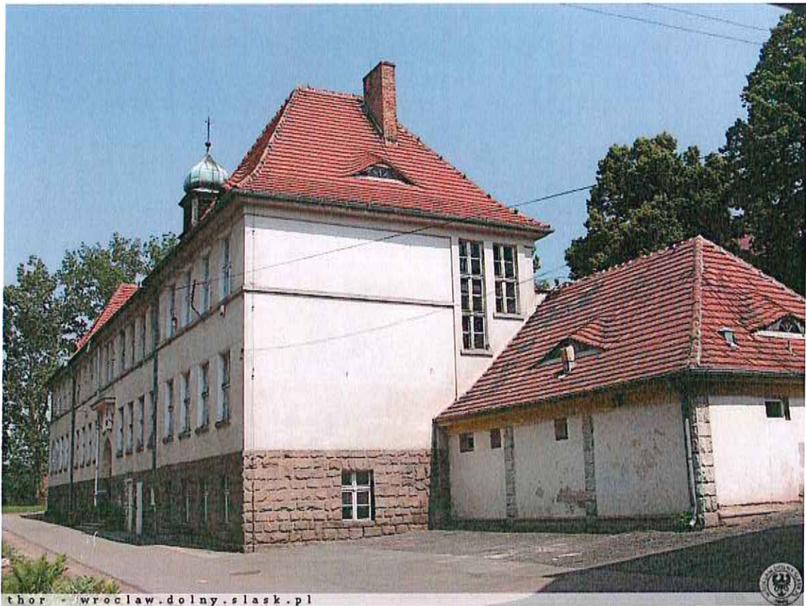
Fot. Nr 5 Obiekt szkoły elewacja boczna (płd.-wsch)
