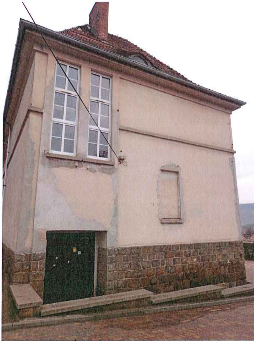
Fot. Nr 6 Elewacja boczna (płn.-zach)
